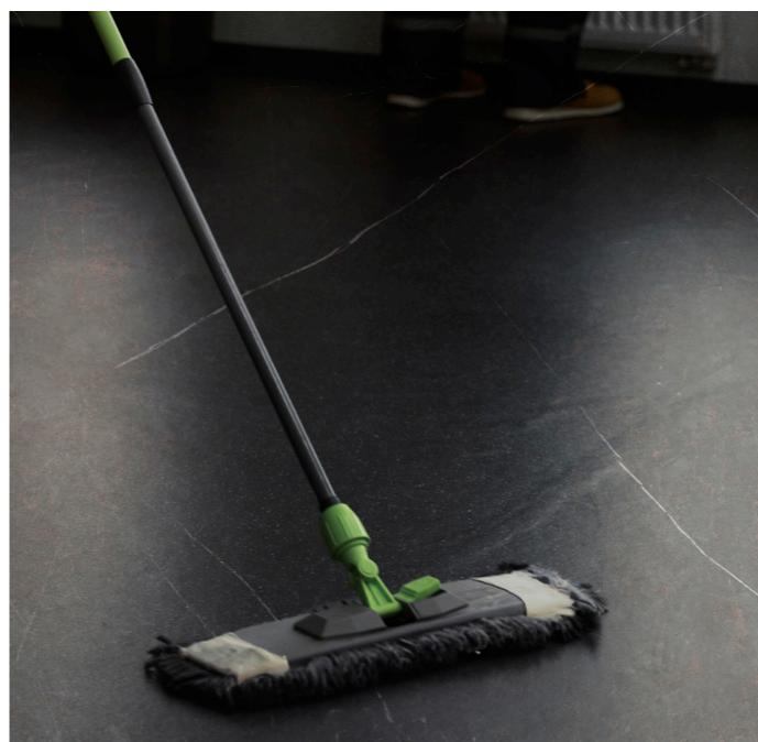
Después de colocar el material es esencial limpiarlos a fondo. Si los restos de lechada no se eliminan correctamente o con rapidez, pueden producirse manchas difíciles de eliminar y pueden crear una película de hormigón que atrapa todo tipo de suciedad.
